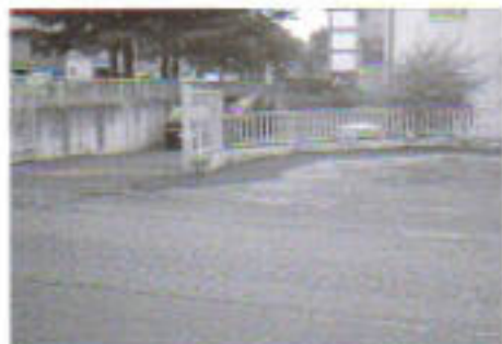
Rampe accessibili in Viale Stelvio
