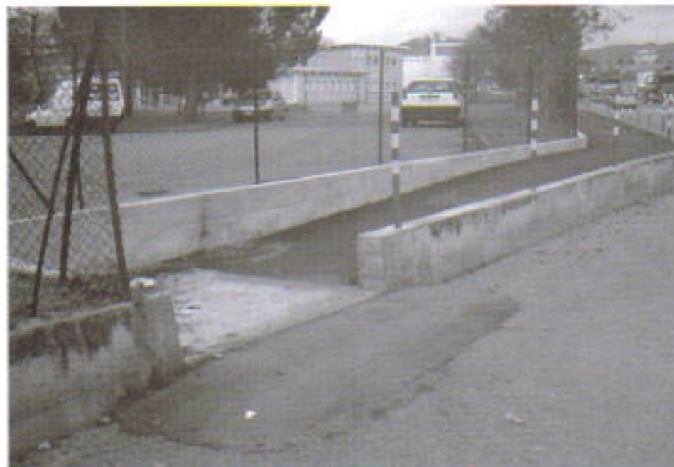
Marciapiede sopraelevato in Via F. M. Malfatti
