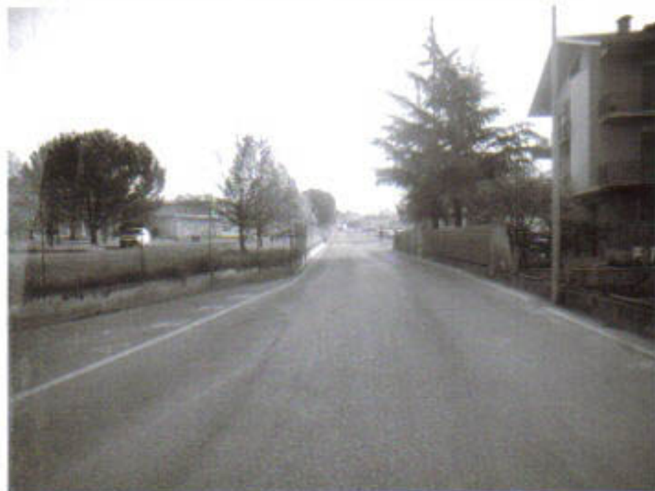
Pericolosa strettoia in via Malfatti sprovvista di marciapiede pedonale.
