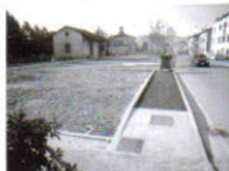
Lavori in corso alla stazione di Trestina.
