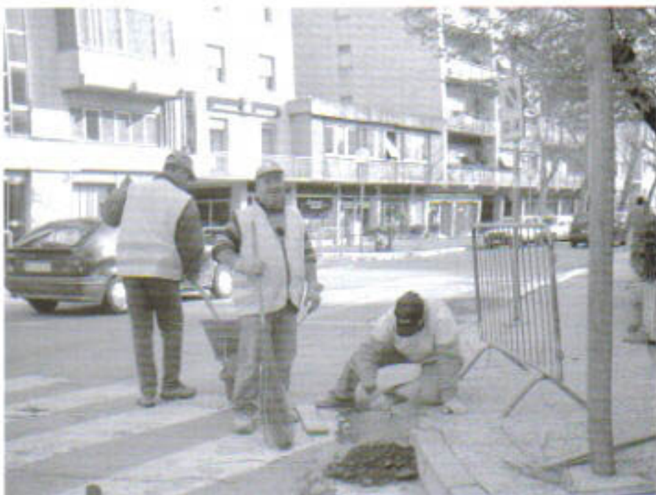
Cantiere di abbattimento e ricostruzione in viale Vittorio Veneto, angolo via Carlo Liviero.
