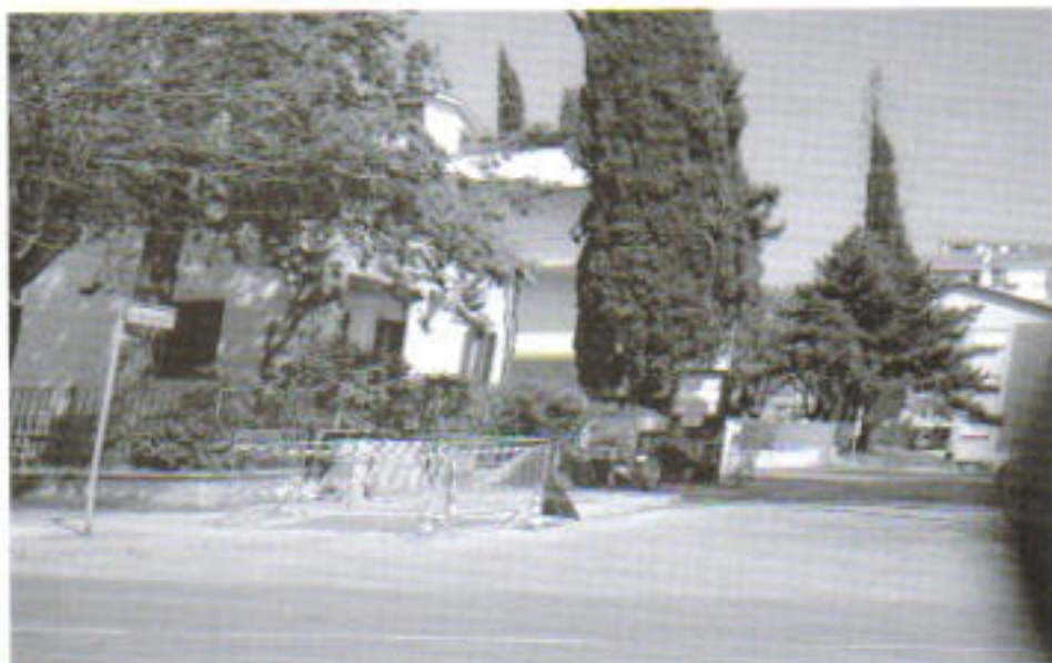
Cantiere di abbattimento e ricostruzione in viale Vittorio Veneto, angolo via IV Novembre
