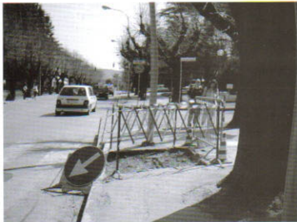
Cantiere di abbattimento e ricostruzione in viale Vittorio Veneto
